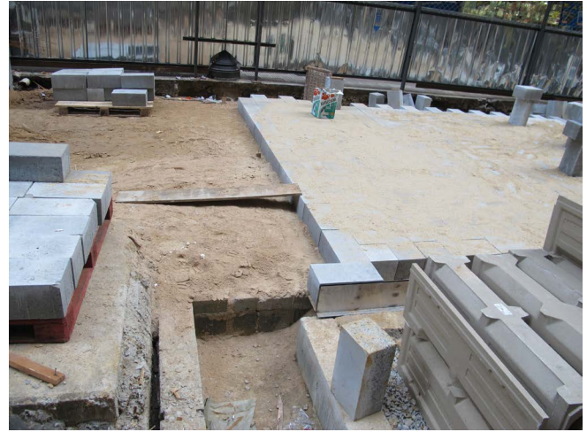
São Paulo, Brasil Canais de drenagem em obras para um projeto de repavimentação de rua.
