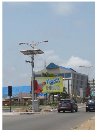
Acra, Gana Iluminação urbana alimentada por energia solar para reduzir a dependência da eletricidade.
