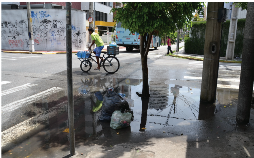
Fortaleza, Brasil. Formação de poça d'água devido à falta de drenagem ou de infraestrutura verde.
